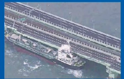
台風21号の被害
