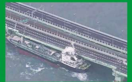
台風21号の被害
